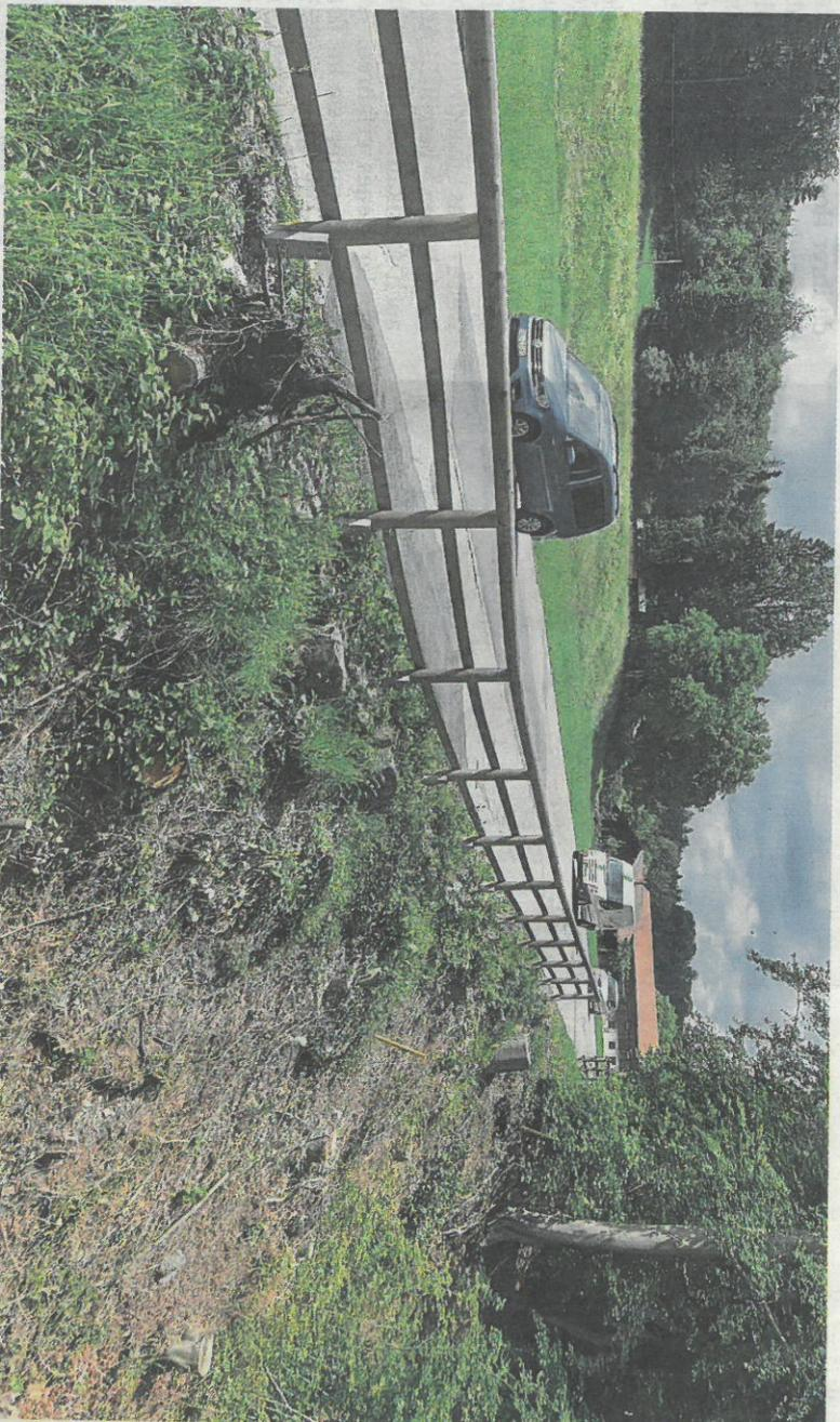
**Unübersehbare Straßenschäden:** Die Töl 7 am Stausee ist auf der Flussseite kurz nach dem Ortsausgang Bad Tölz ein gutes Stück abgesackt. Ab Juli beginnen die Sanierungsarbeiten. Die Straße ist bis Herbst gesperrt.
